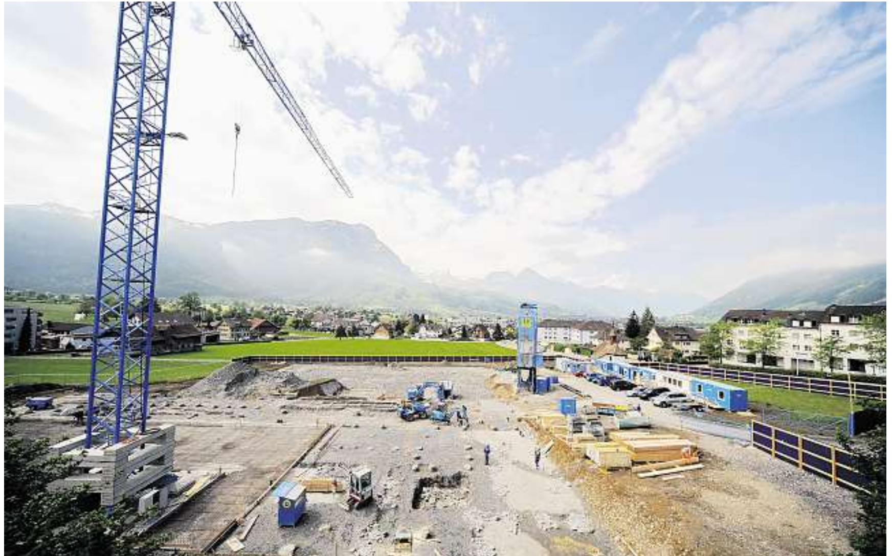
Grossbaustelle zwischen Ibach und Schwyz: Auf diesem Gelände entstehen 40 neue Eigentumswohnungen.
